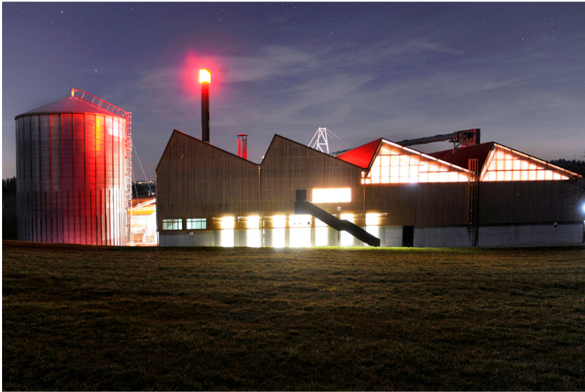
Heizzentrale mit Schnitzzellagerhalle bei Nacht:
